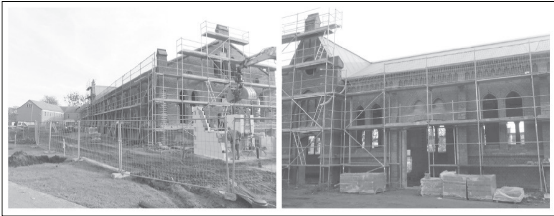
Sanierung der Exerzierhalle, 2013
