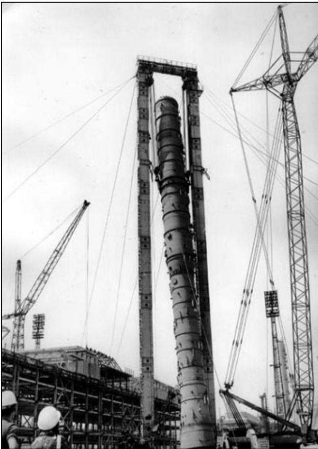
Abb. 3: Aufbau der Ammoniak-Anlagen 1972-1974
