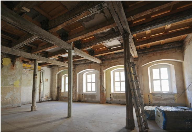
Abb. 73: Wittenberg, Collegienstraße 54, Augusteum, Vorderhaus, Erdgeschoss, wiederhergestellte Größe des ehemaligen Hörsaals der Bauphase 1785–1802. Die mittlere hölzerne Säule musste aus statischen Gründen durch eine Stahlstütze ersetzt werden, Aufnahme 2016
