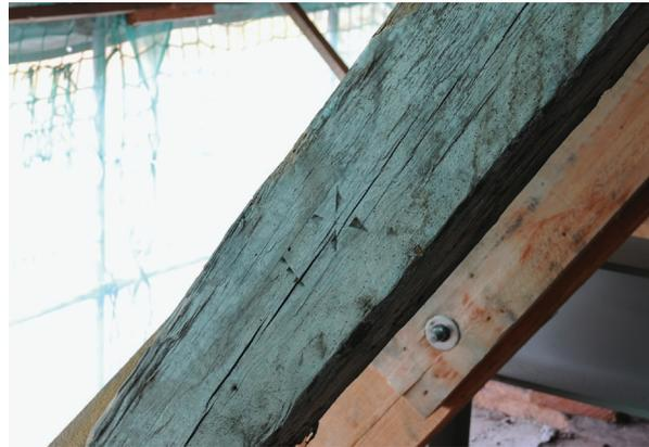
Abb. 31: Wittenberg, Collegienstraße 54, Augusteum, Dachgeschoss, Vorderhaus, Sparren 6 bis 9, Abbundzeichen römisches Zahlensystem, verwendet auf der Nordseite des Vorderhauses und Westseite des Seitenflügels, Aufnahme 2015
