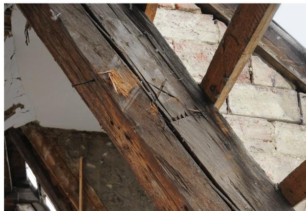
Abb. 33: Wittenberg, Collegienstraße 54, Augusteum, Dachgeschoss, Seitenflügel, Sparren 15, Abbundzeichen römisches Zahlensystem mit verketteten Fähnchen, verwendet auf der Ostseite und dem stehenden Stuhl des Seitenflügels, auch auf wiederverwendeten Hölzern des Vorderhauses zu sehen, Aufnahme 2015
