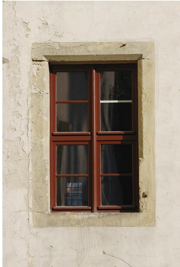
Abb. 59: Wittenberg, Collegienstraße 54, Augusteum, Vorderhaus, Südfassade, Fenster 016aS-F1 (EG, Raum 016a) mit einfach gefastem, in Karnies auslaufendem Gewände, 1581–82, seitliche Gewändesteine 1785–1802 nach oben verlängert, Aufnahme 2011
