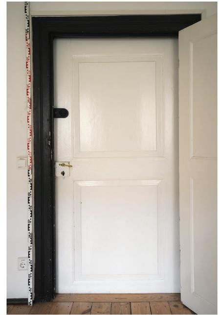
Abb. 39: Wittenberg, Collegienstraße 54, Augusteum, Vorderhaus, Tür 118-136-T1, Ansichtsseite Raum 118 (1. OG), Rahmentür mit zwei einseitig gestemmt Holzfüllungen und leicht abgesetzten Spiegeln, Füllungen von Profil gerahmt (beidseitig eingezogener Wulst), vermutl. um 1817, Aufnahme 2013
