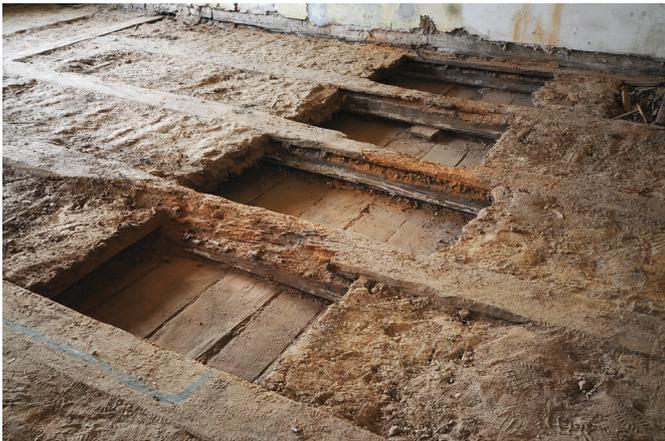
Abb. 62: Wittenberg, Collegienstraße 54, Augusteum, Vorderhaus, Räume 221–222 (2. OG), Blick nach Nordosten, Deckenbalken vom 1. Obergeschoss von oben freigelegt. Sichtbar sind die Farbfassung an der Unterseite und die Lehmstakenfüllung, die nicht bis zur Unterkante der Deckenbalken reicht, weshalb diese von unten sichtbar waren (1581–82). Decke von unten mit Brettschalung verkleidet (1785–1802), Aufnahme 2016
