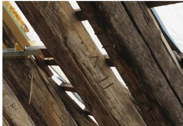
Abb. 32: Wittenberg, Collegienstraße 54, Augusteum, Dachgeschoss, Vorderhaus, Sparren 12 und 13, Abbundzeichen römisches Zahlensystem mit Fähnchen, verwendet auf der Südseite des Vorderhauses, Aufnahme 2014
