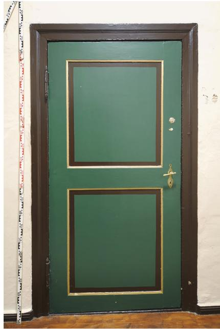
Abb. 38: Wittenberg, Collegienstraße 54, Augusteum, Vorderhaus, Tür 118-136-T1, Ansichtsseite Raum 136 (1. OG), Rahmentür mit zwei einseitig gestemmt Holzfüllungen und leicht abgesetzten Spiegeln, Füllungen von Profil gerahmt (beidseitig eingezogener Wulst), vermutl. um 1817, Aufnahme 2013
