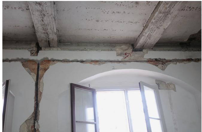
Abb. 63: Wittenberg, Collegienstraße 54, Augusteum, Seitenflügel, Raum 303 (3. OG bzw. unteres DG), Blick nach Osten, Deckenbalken gliedern die Untersicht der Decke, Auflager der Balken mit freigelegter Rahmung aus schwarzen Begleitstrichen und roten Ornamenten, 1581–82, Aufnahme 2015
