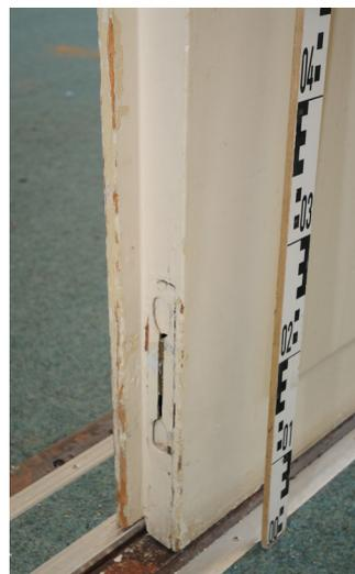
Schubriegel unten im Standflügel, mit abgebrochenem Hebel
