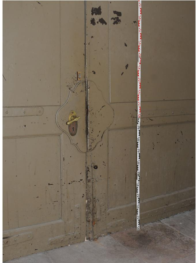
022N-T1, Ansichtsseite R 022, Brettaufdupplung für Einsteckschloss, Schubriegel am Standflügel
