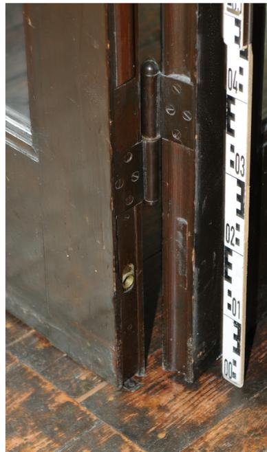
Aufschraubband mit runden Köpfchen an mittleren Flügeln; Schubriegel in äußeren Standflügeln eingelassen
