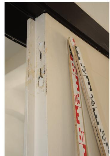
Schubriegel oben im Standflügel, mit abgebrochenem Hebel
