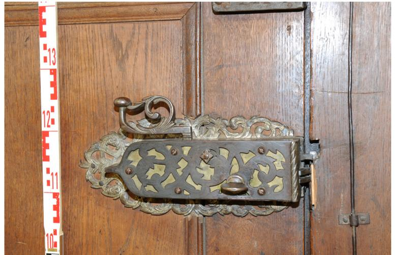
Kastenschloss (vermutl. 17. Jh.), welches nachträglich angebracht wurde, durchstößt das Füllungsprofil.
