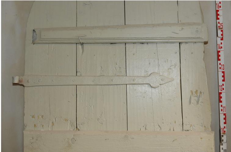
005S-T1, Türblatt Ansichtseite R 005 mit oberem Langband und eingeschobener Gratleiste, ausgebrochene Kante des Türblatts, steht in R 007b
