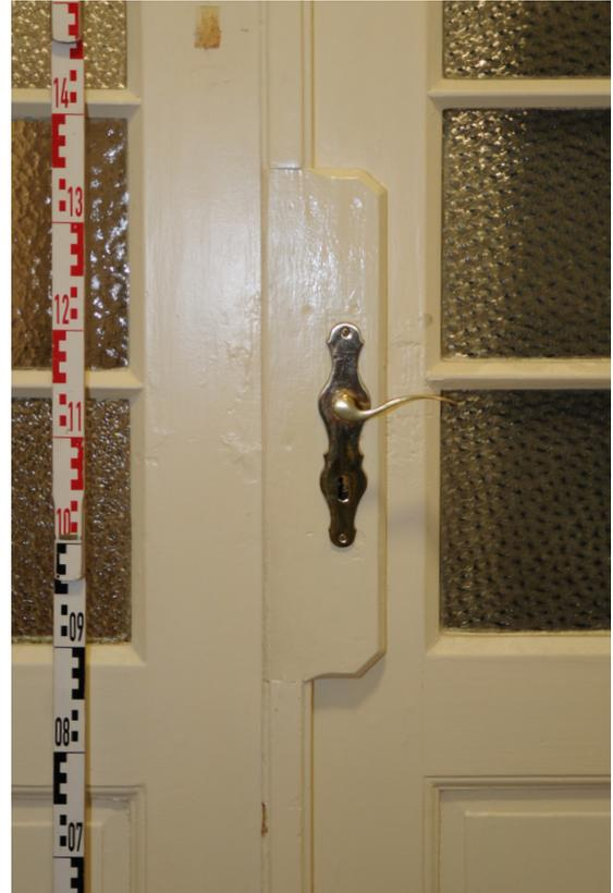
Ansichtsseite R 134, aufgedoppeltes Rahmenholz, um Einsteckschloss aufzunehmen, Schlagleiste in dem Bereich entfernt
