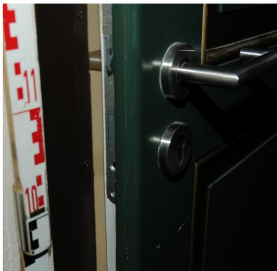
108-135-T1 mit aufgedoppeltem Rahmen (links) und aufgesetzten Profilleisten sowie Spiegeln (rechts)
