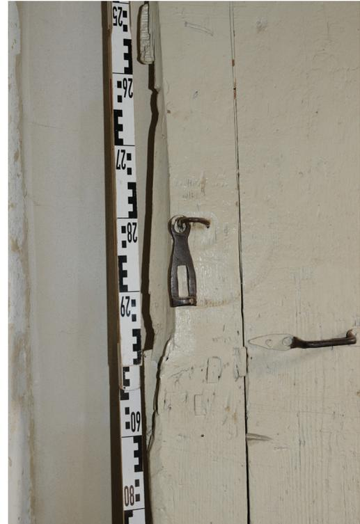
005S-T1, Türblatt Ansichtseite R 007b mit Bügelgriff und Überwurffalle, Kante des Türblatts z. T. ausgebrochen
