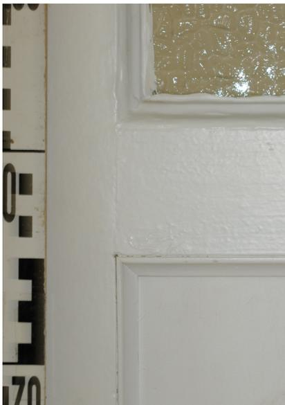
obere zwei Füllungen, untere Füllung und Profilleiste ersetzt (ebenso unterste Füllung)
