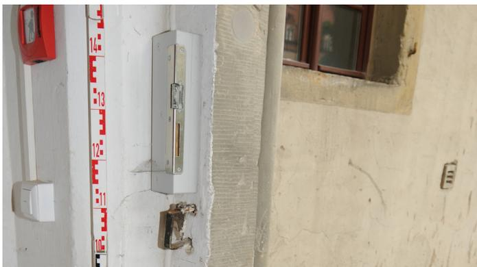
Ansichtsseite R 017a, Kloben für bauzeitliches Kastenschloss und aufgesetztes Holz für modernes Ergänzungsschloss
