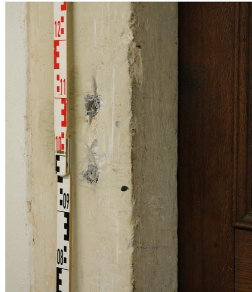
In das Gewände eingelassene Eisenstäbe, vermutl. Reste einer früheren Verriegelung
