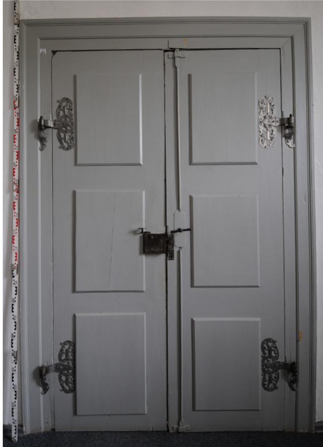
003-002-T1, Ansichtseite R 002, die beiden unteren überschobenen Füllungen sind im Gehflügel größer als im Standflügel
