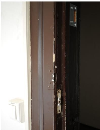
sekundäre Anschlagleiste für 136-118-T1, in Futterzarge eingelassene Rollenfalle
