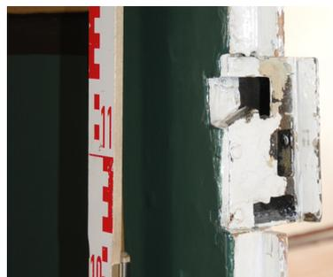
Schließblech mit Anschlag für Kastenschloss am Standflügel
