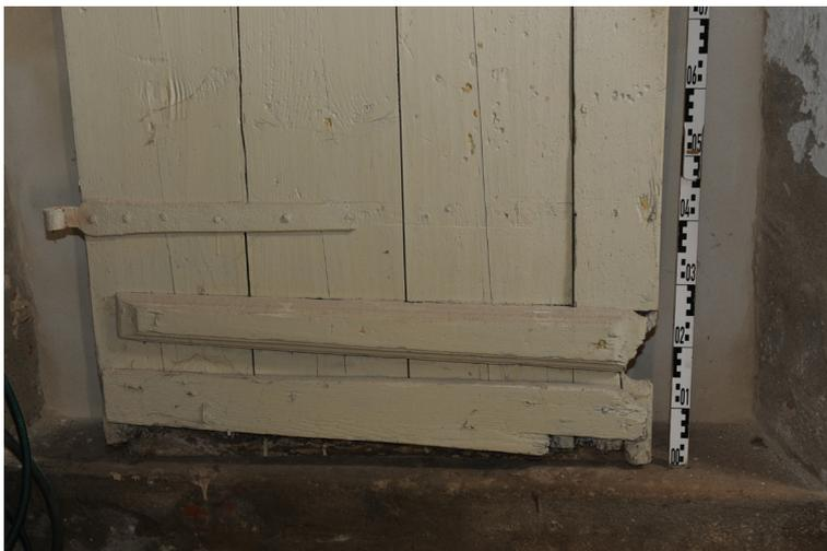
005S-T1, Türblatt Ansichtseite R 005 mit unterem Langband und eingeschobener Gratleiste, Kante des Türblatts z. T. ausgebrochen, steht in R 007b
