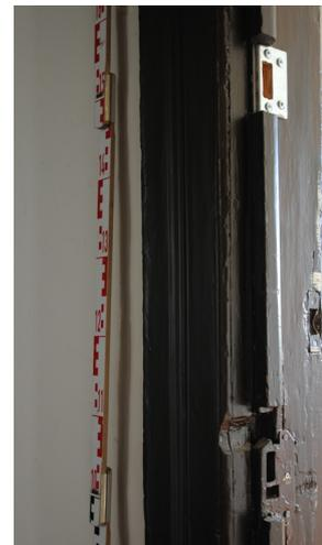
Futterzarge mit Schließblechen, und sekundärer Anschlagleiste
