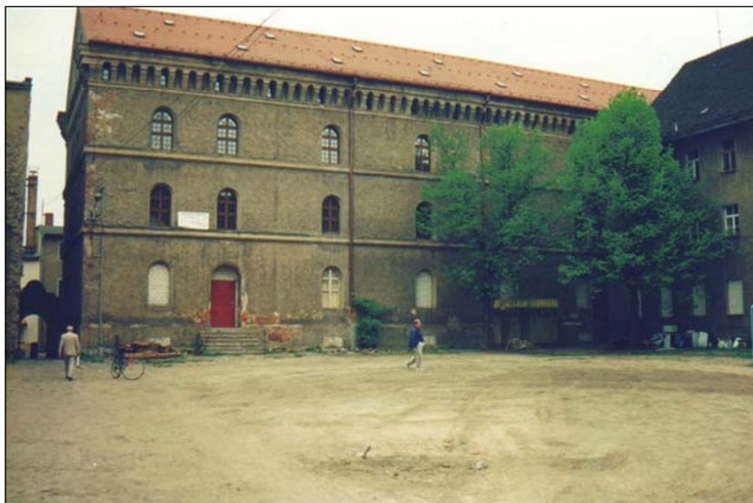
Tafel 12: Stiftung Leucorea, Sitz des Instituts für Hochschulforschung: vor der Sanierung 1991 (oben), nach der Sanierung (2000)
