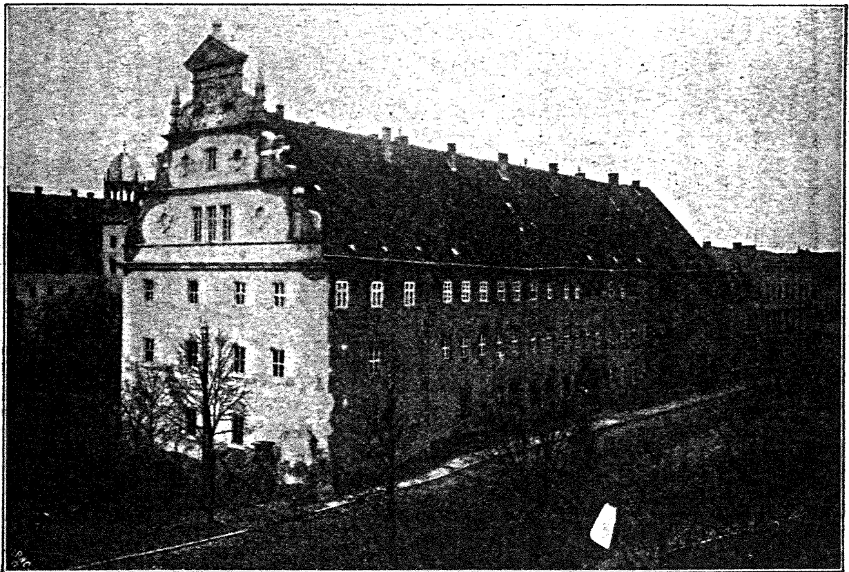
Auditoriengebäude der Wittenberger Hochschule.
