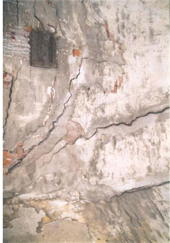
Rissbildung im Mauerwerk des Turmes, die Standsicherheit wird davon aber nicht berührt. Eine Mauerwerksverpressung wird möglich sein.
